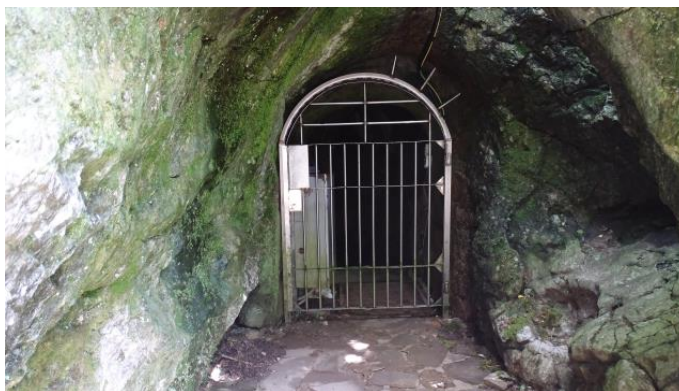
Входната решетка на пещерата „Леденика“, ограничаваща полета на прилепите в \frac{3}{4} от площта си.
