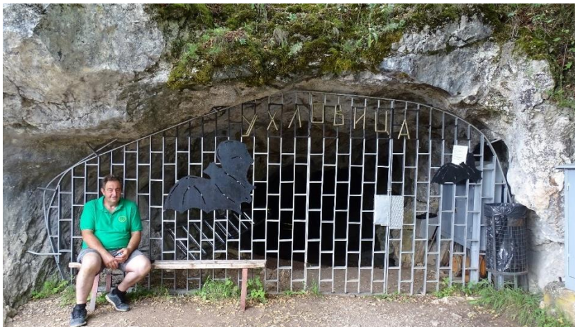
Входната решетка на пещерата „Ухловица“ е неподходяща, защото ограничава полета на прилепите с цялата си площ. Размер на клетката е 13 см x 28 см
