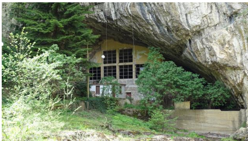
Преградно съоръжение на входа на пещерата „Андъка“, несъобразено с изискванията на EUROBATS и пренятстващо свободния полет на прилепите на входа на пещерата.
