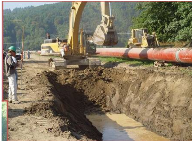
Снимка 0-2 Пример за изкопаване на траншея
